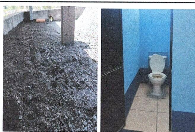
Foto 4: Reforzar la terraza de los baños por encima
